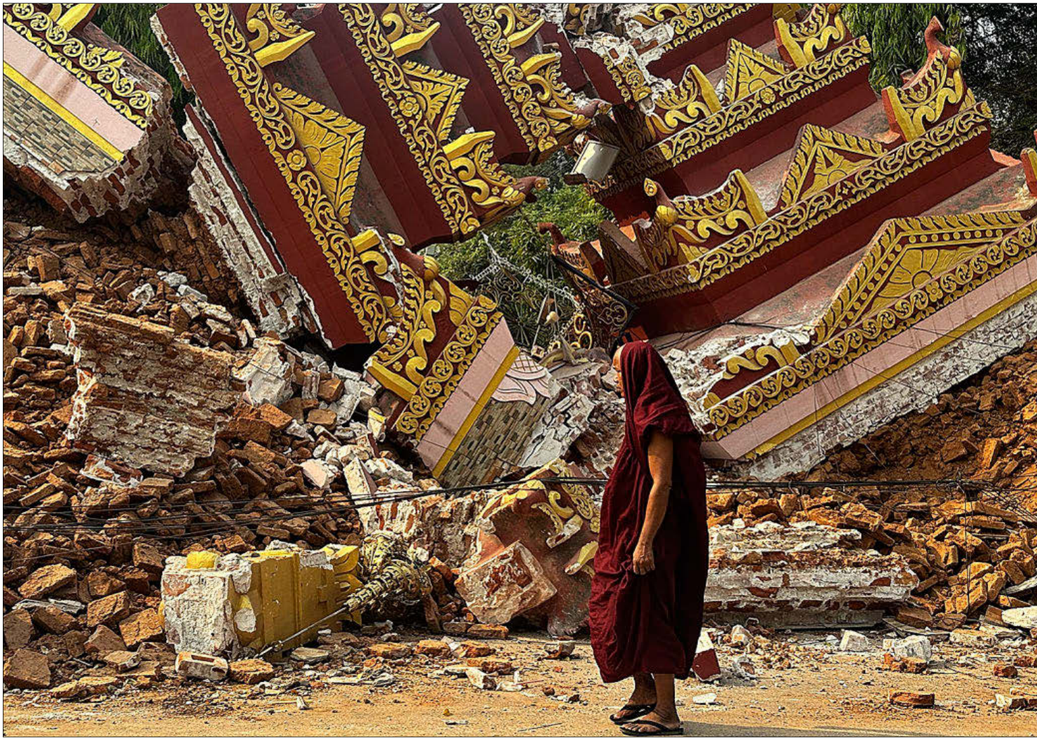
Un monje budista observa una pagoda derrumbada por el terremoto, ayer en Mandalay (Birmania). THEIN ZAW / AP FOTO
